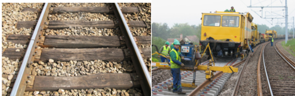
Rails courts sur traverses bois Longs Rails soudés sur traverses béton
