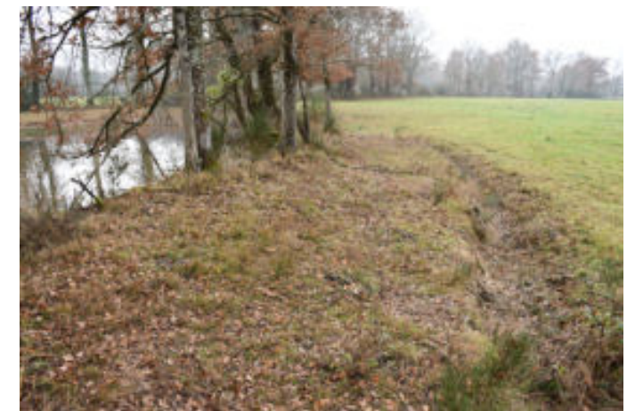
Détail de la chaussée de l'Étang Luque et de son déversoir
