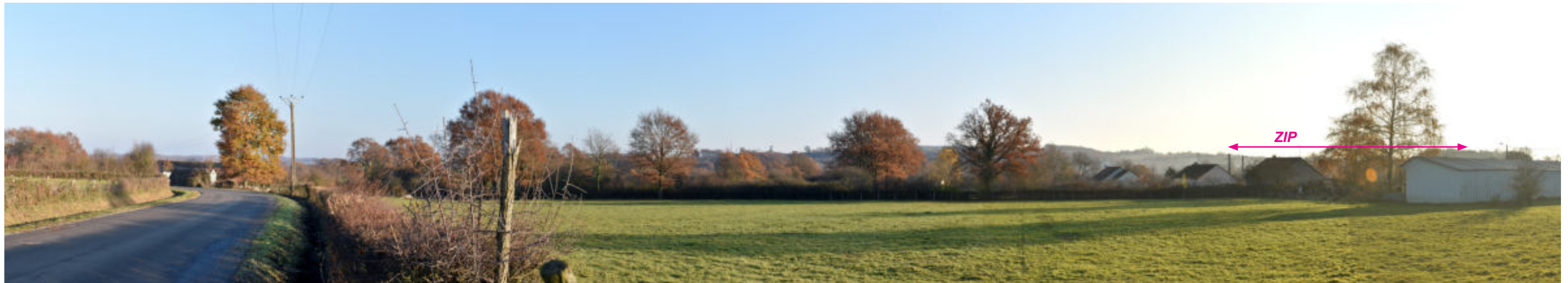
Photographie 64 : Vue très partielle de la ZIP, limitée à sa partie haute, depuis la rue Chassidoux située en lisière sud du bourg de Chaillac
