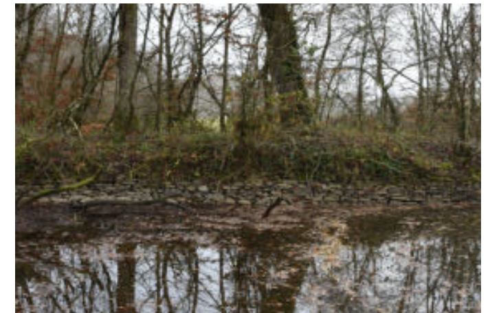
Détail de l'appareillage de la digue de l'Étang Vieux
