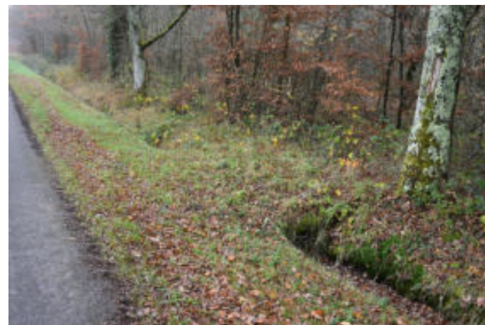
Fossé et accès busé à une parcelle enrichie
