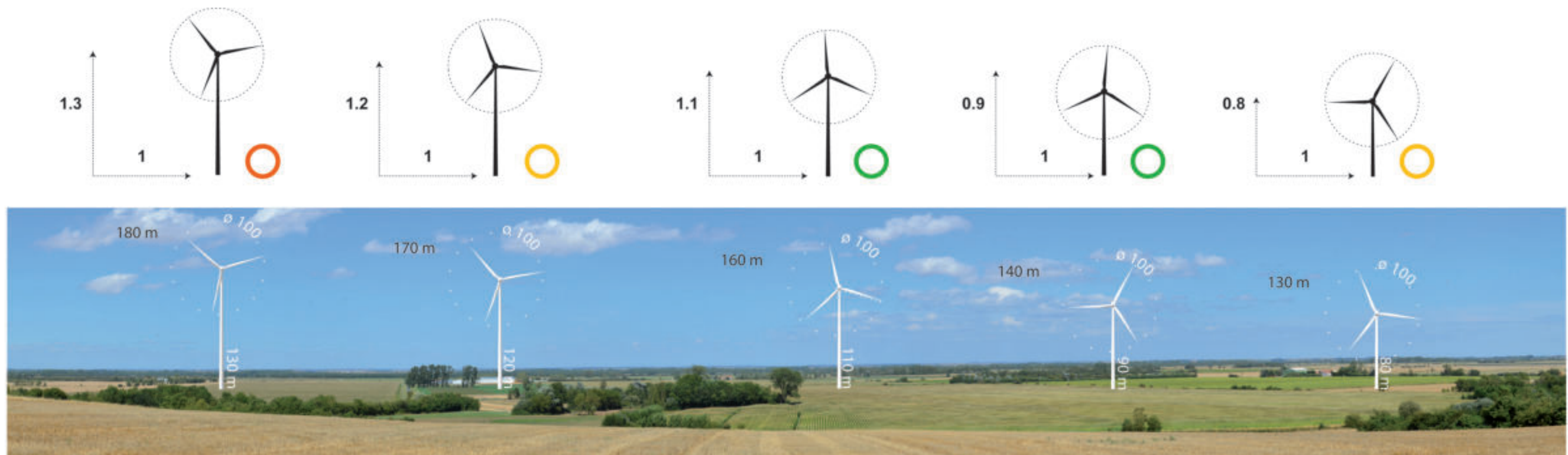
Figure 22 : Exemple du rapport de proportion entre le diamètre du rotor et la hauteur de mât.
