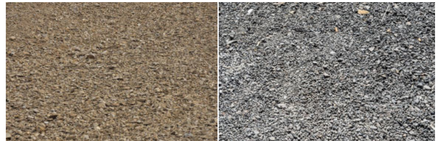
Photographie 177 : Texture des pistes en concassé calcaire / granit.
