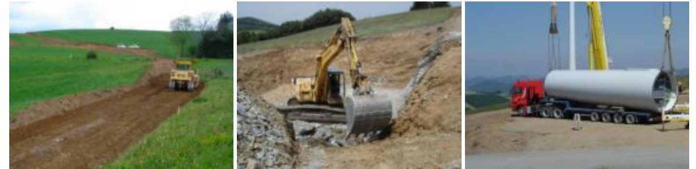
Photographie 180 : Illustration d'un chantier éolien
