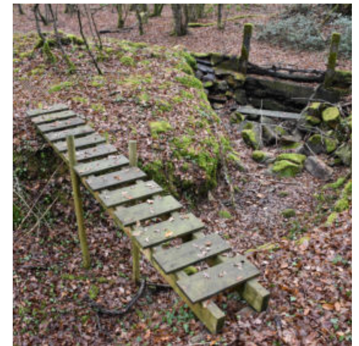
Photographie 162 : Ponton en bois permettant de franchir le déversoir de l'Étang Vieux
