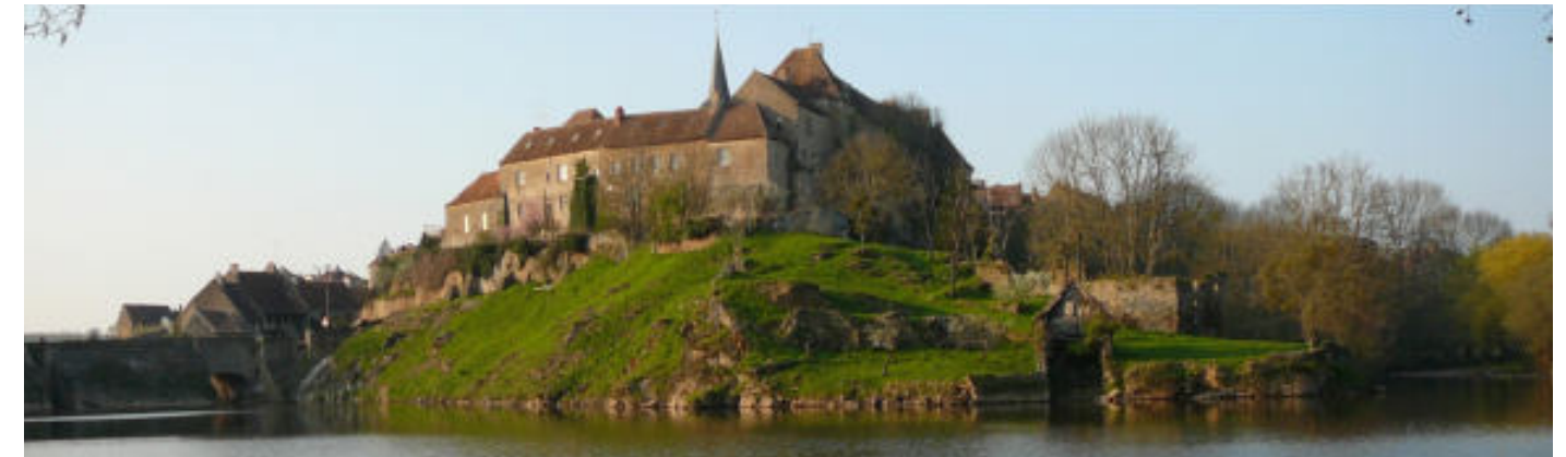
Photographie 187 : Le prieuré de Saint-Benoît-du-Sault et la chaussée de l'étang (digue). Source : WikiCommons.
