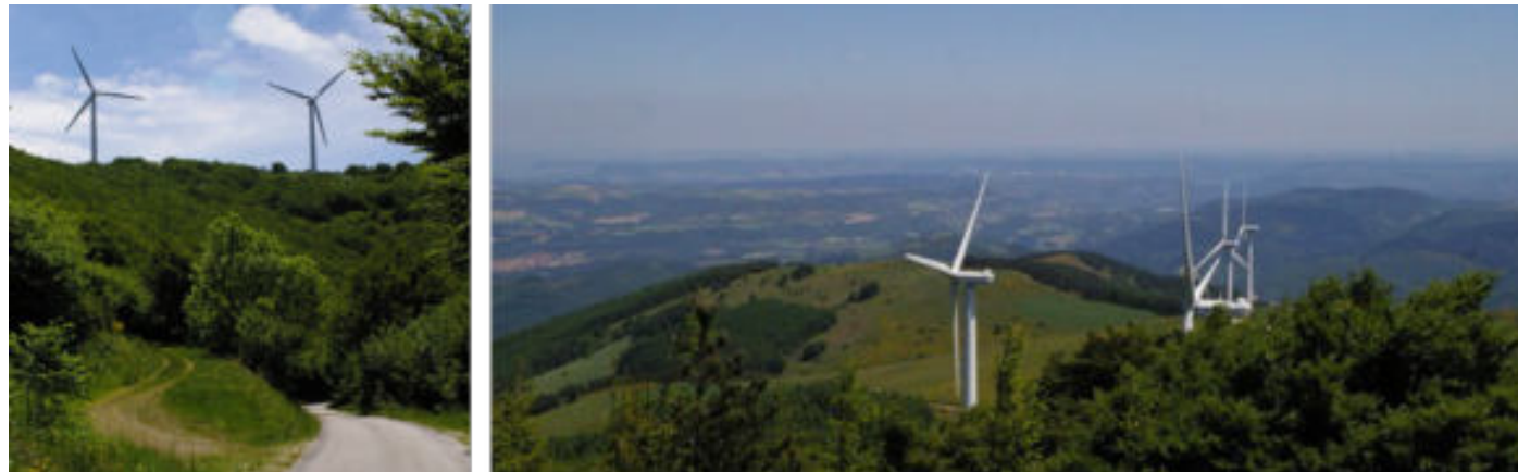
Photographie 178 : Vue en contre-plongée et vue en plongée du parc éolien de Merdélou (photo : F. Bonnenfant).
