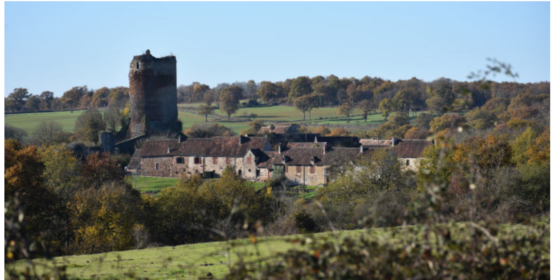
Photographie 212 : Point de vue sur le château et le hameau de Brosse depuis le sentier de randonnée Brosses-Moulin de Seillant.
