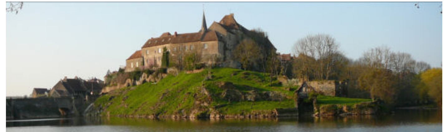
Photographie 30 : Le prieuré de Saint-Benoît-du-Sault et la chaussée de l'étang (digue). Source : WikiCommons.
