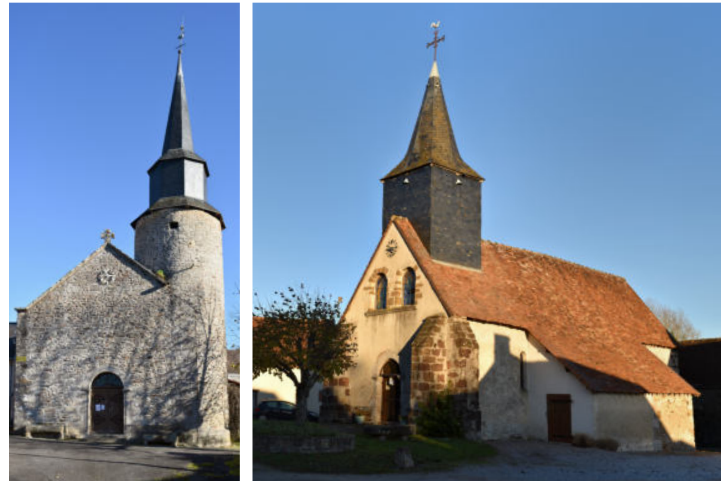
Photographie 148 : L'église Saint Pierre et Saint-Paul à Jouac à gauche et l'Église Saint-Martial de Bonneuil à droite, deux édifices non protégés aux enjeux modérés
