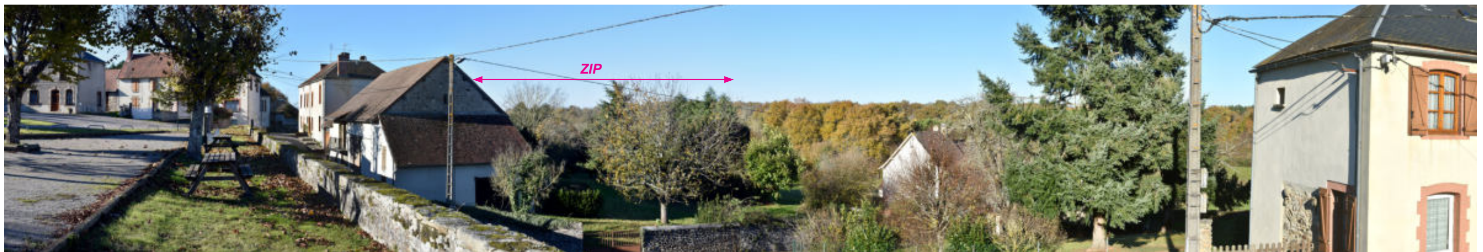
Photographie 109 : Perception visuelle de la ZIP depuis la pointe nord-est de la place centrale de Cromac à proximité du boulodrome
