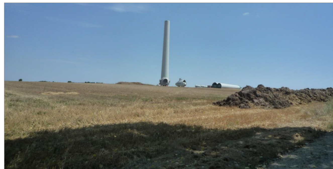
Photographie 31 : Exemple de stockage de terre durant un chantier éolien
