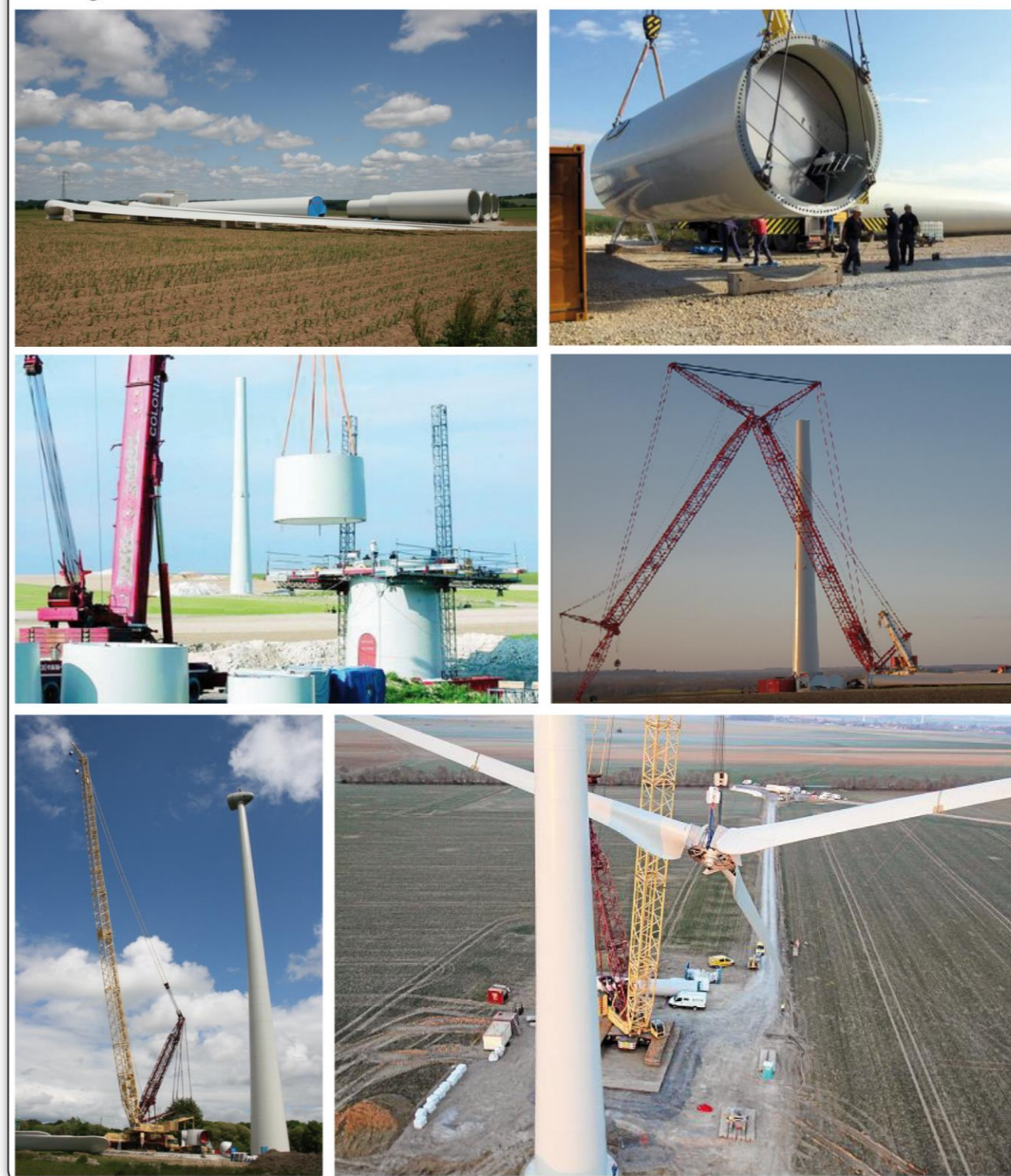
Montage d'une éolienne
