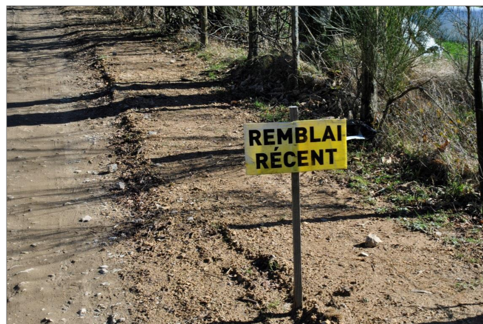
Photographie 32 : Exemple de remblai des tranchées électriques le long d'une piste
