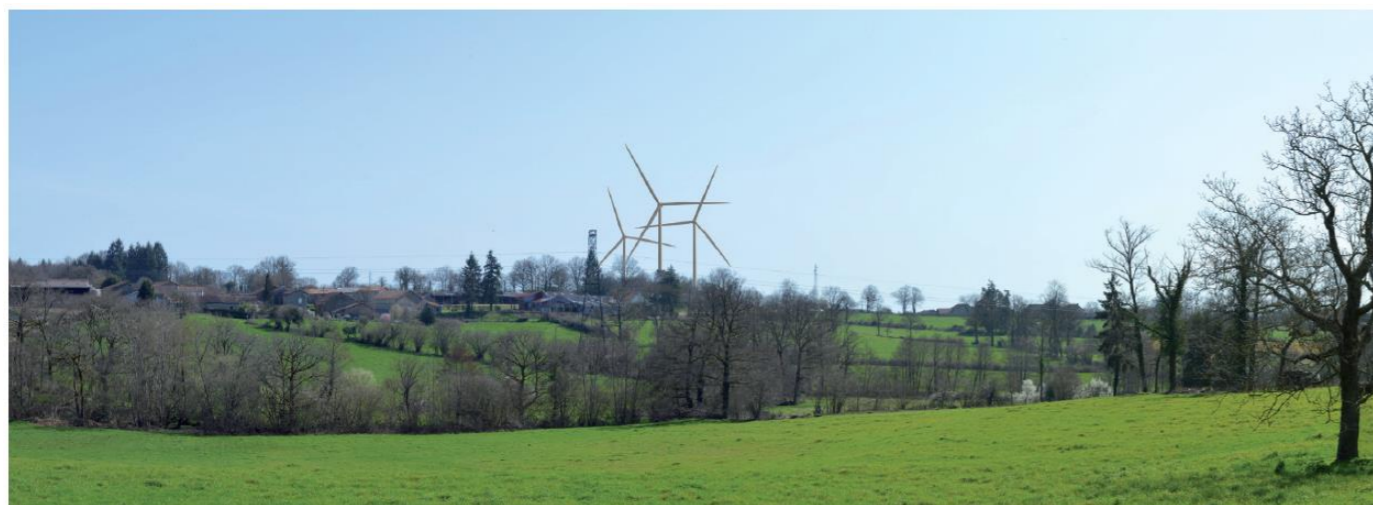
Photographie 42 : Vue sur le projet éolien depuis le hameau de la Valette, au sud-ouest du périmètre de protection du dolmen de Rouffignac, sans covisibilité possible (Vue 19 du carnet de photomontages) (Source : ENCIS Environnement)
