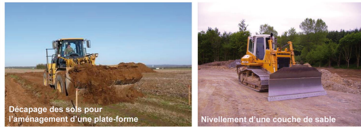
Photographie 26 : Exemples d'engins de travaux de VRD
