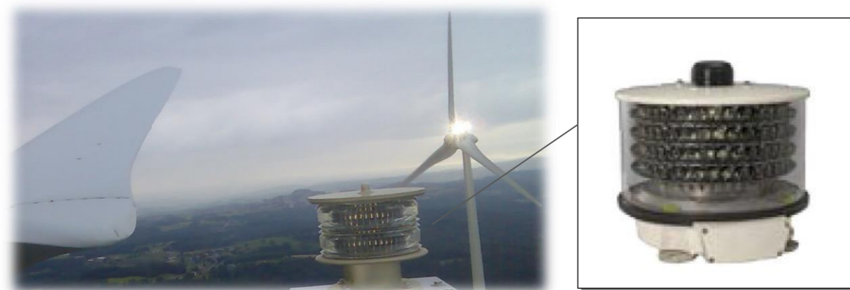
Figure 39 : Balisage d'une éolienne
