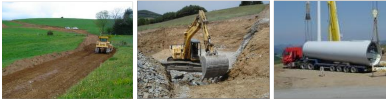
Photographie 34 : Illustration d'un chantier éolien (Source : ENCIS Environnement)
