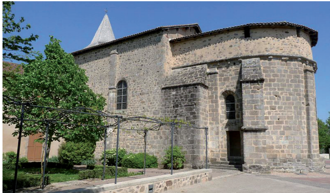
Photographie 28 : Eglise Saint-Etienne à Esse (MH 3).
