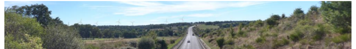
Photomontage des parcs éoliens des Boucles du Vincou et de Croix de la Pile - Réalisé depuis Sissac sud au franchissement de la N147
