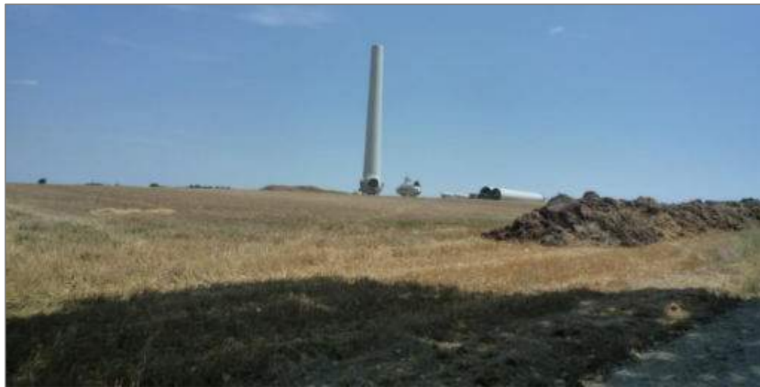
Photographie 57 : Exemple de stockage de terre durant un chantier éolien
