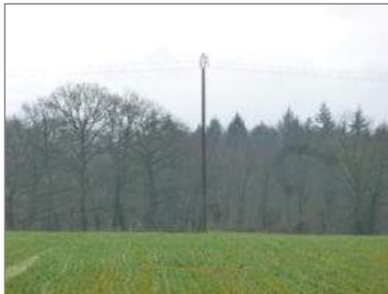
Photographie 24 : Ligne HTA traversant la ZIP (source : ENCIS Environnement)
