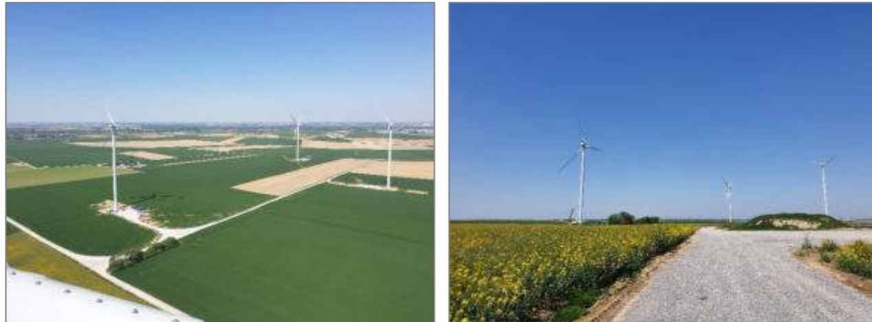
Photographie 51 : Exemples de plateformes de montage et de pistes (source : wpd onshore France)
