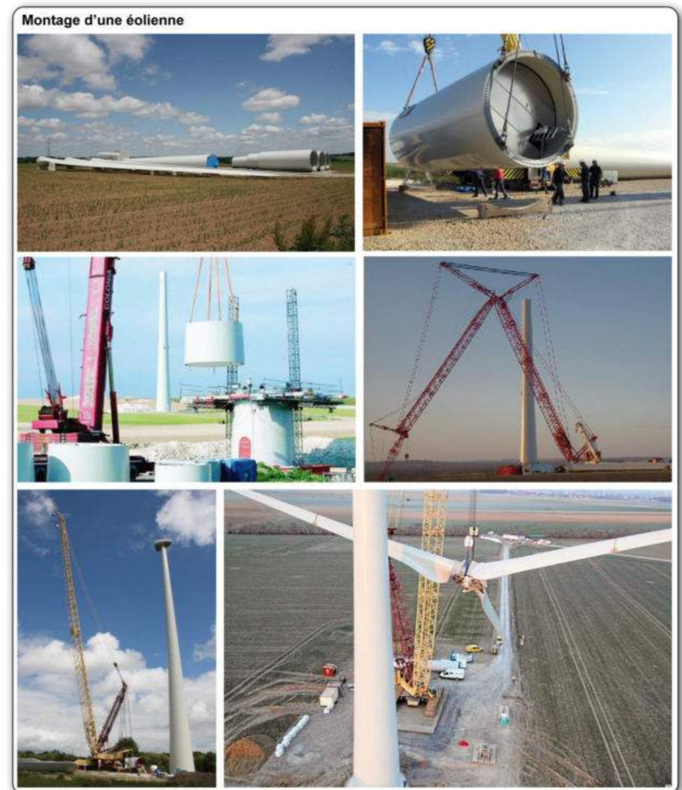
Photographie 55 : Phases d'assemblage d'une éolienne
