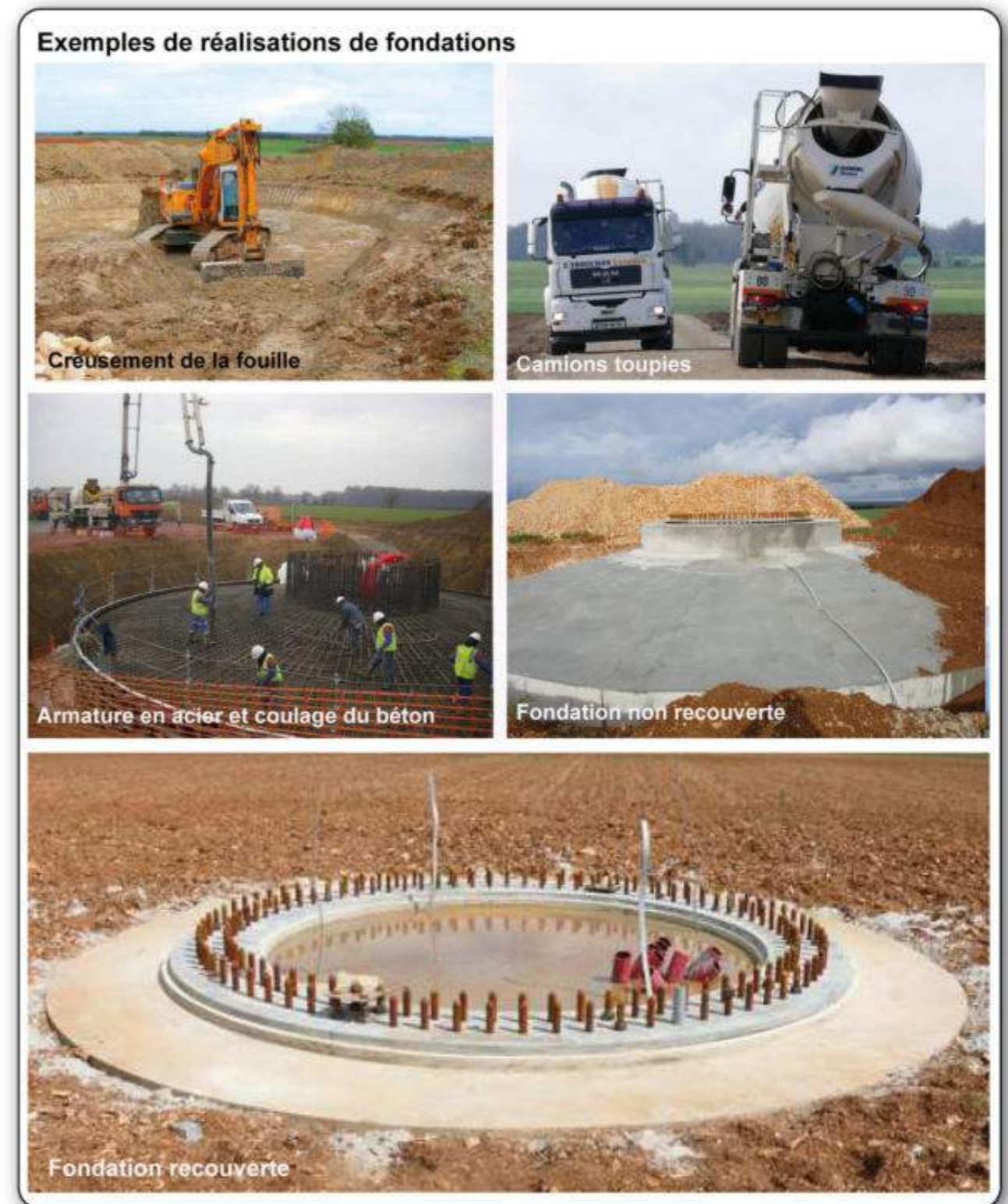
Photographie 53 : Etapes de réalisation d'une fondation d'éolienne
