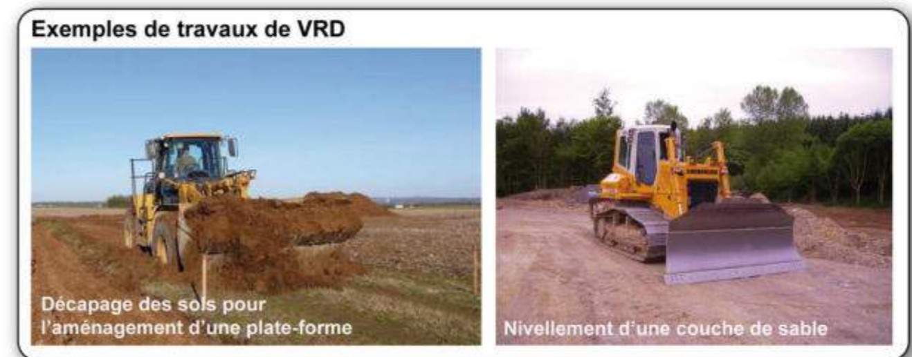
Photographie 52 : Exemples d'engins de travaux de VRD
