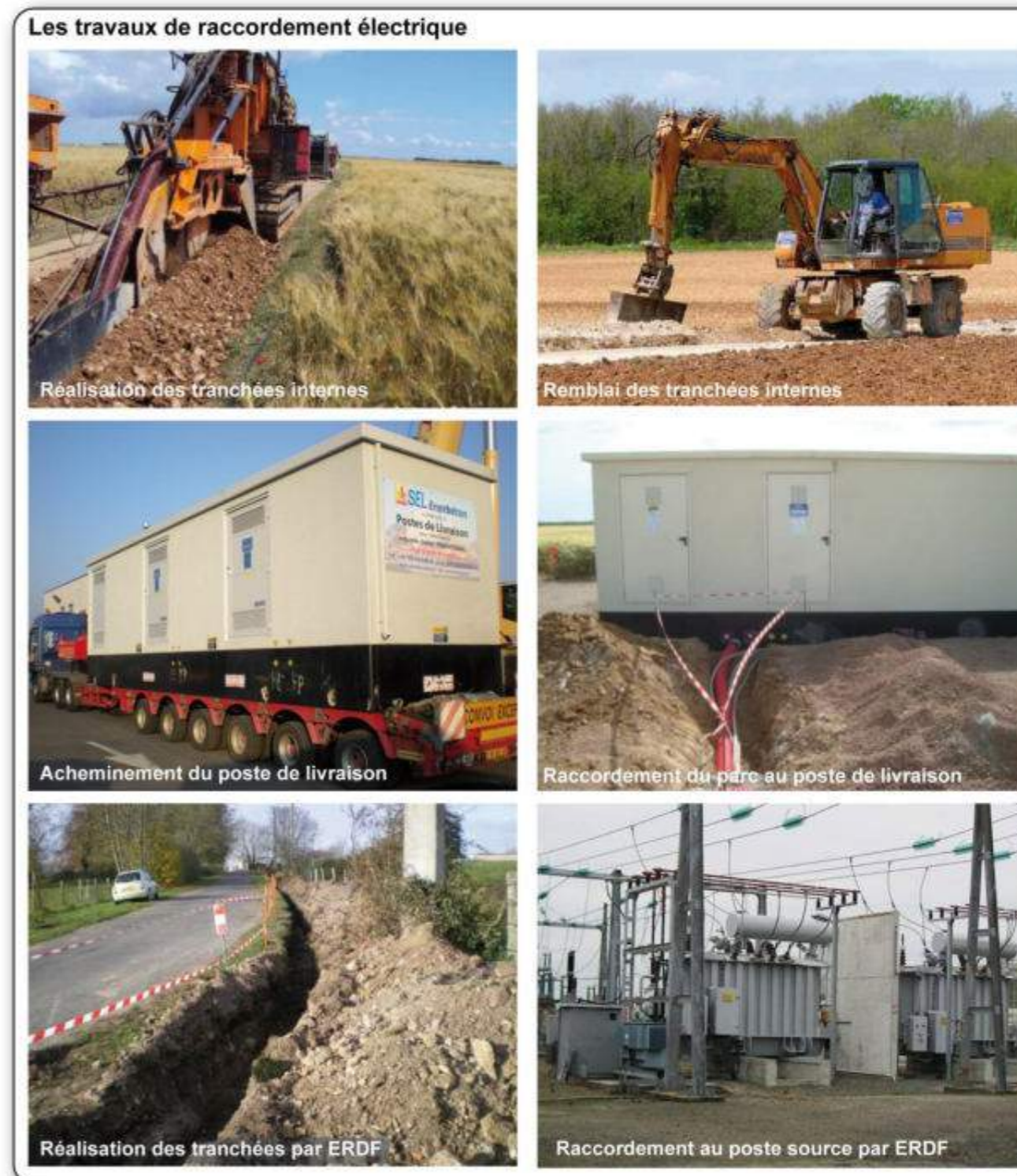
Photographie 54 : Travaux de raccordement électrique
