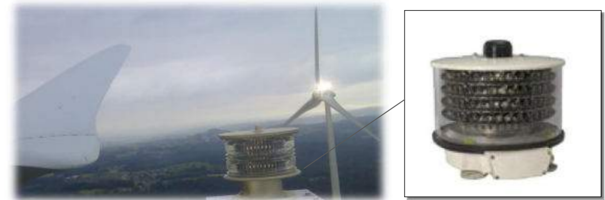
Figure 33 : Balisage d'une éolienne.
