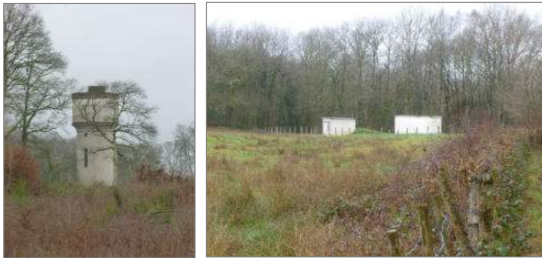
Photographie 14 : Château d'eau et captage abandonné à proximité du site (source : ENCIS Environnement)
