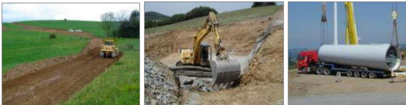
Photographie 60 : Illustration d'un chantier éolien
