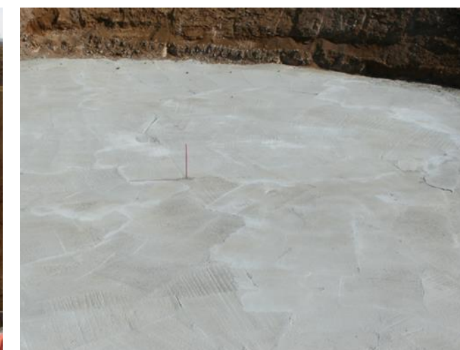
Béton de propreté
