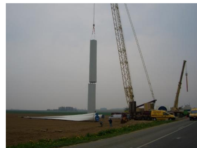
Assemblage des tronçons du mât
