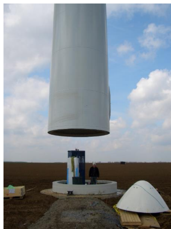
Montage de la base du mât
