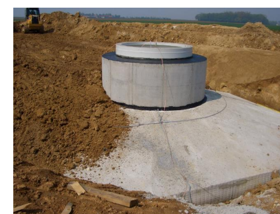
Figure 12 : Remblaiement des fondations (Source : EOLISE et ECOTERA)
