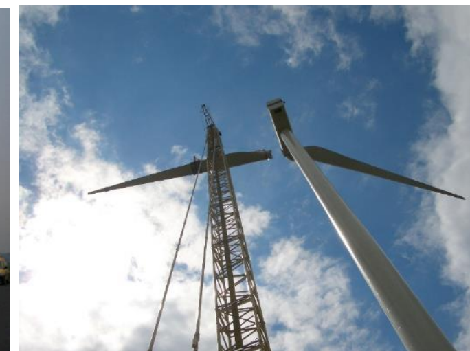
Assemblage des pales
