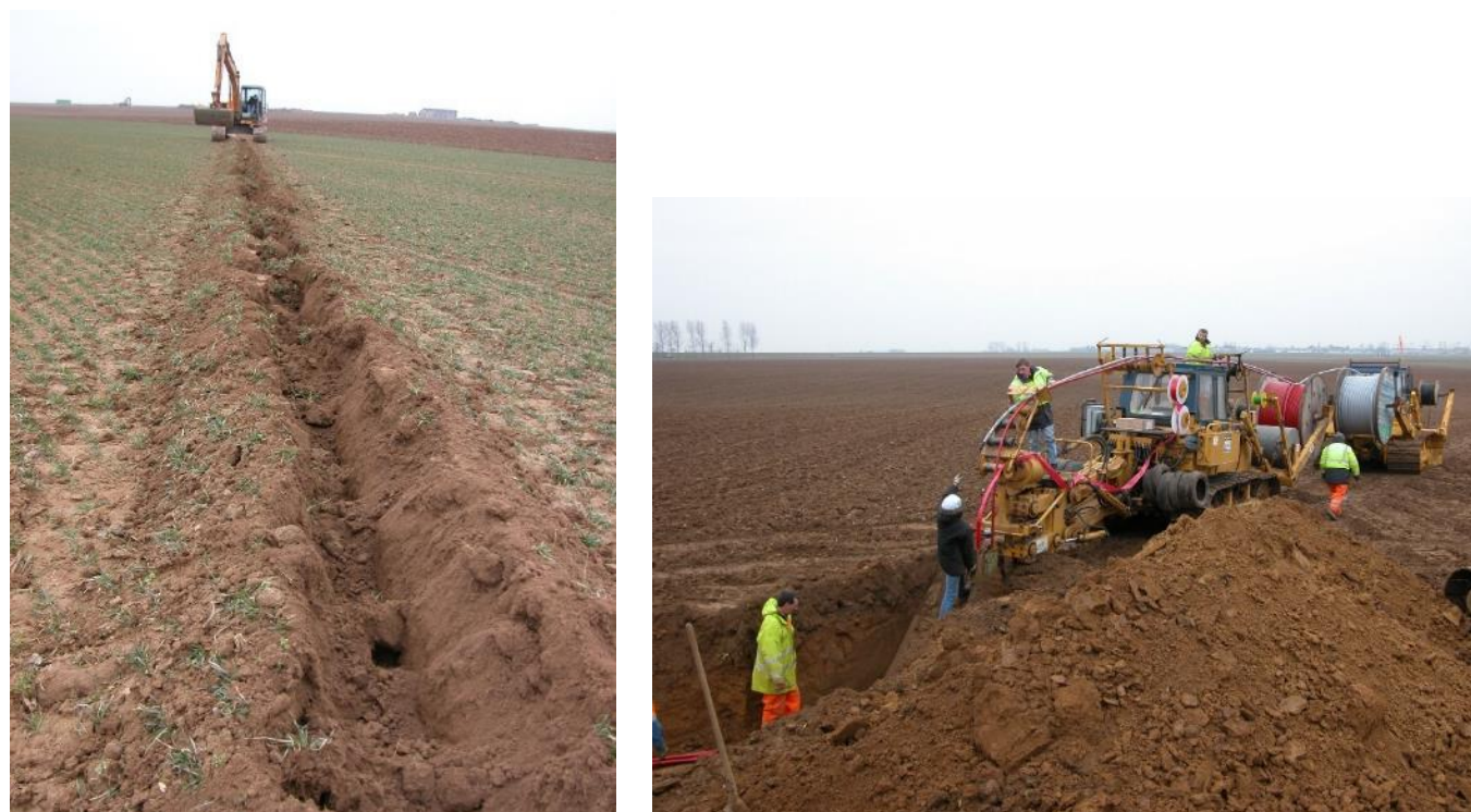
Figure 14 : Photographies d'une opération de raccordement (Source : EOLISE et ECOTERA)
