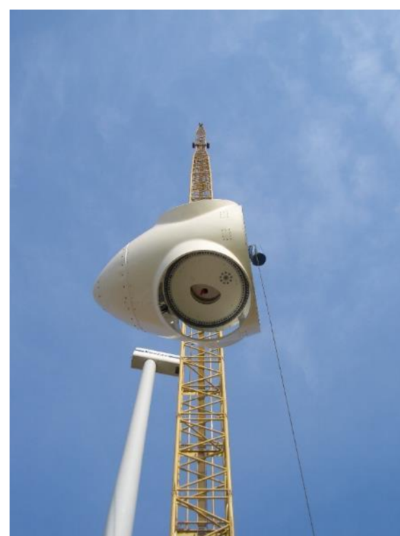
Assemblage du rotor
