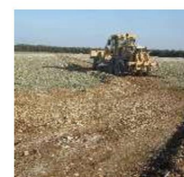
Décapage pour câblage
