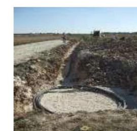
Pose de réseaux HTA
