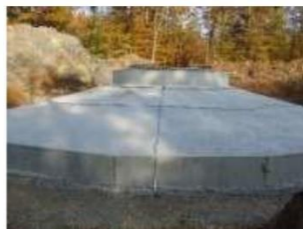
Massif d'éolienne avec ceinture équipotentielle pour MALT
