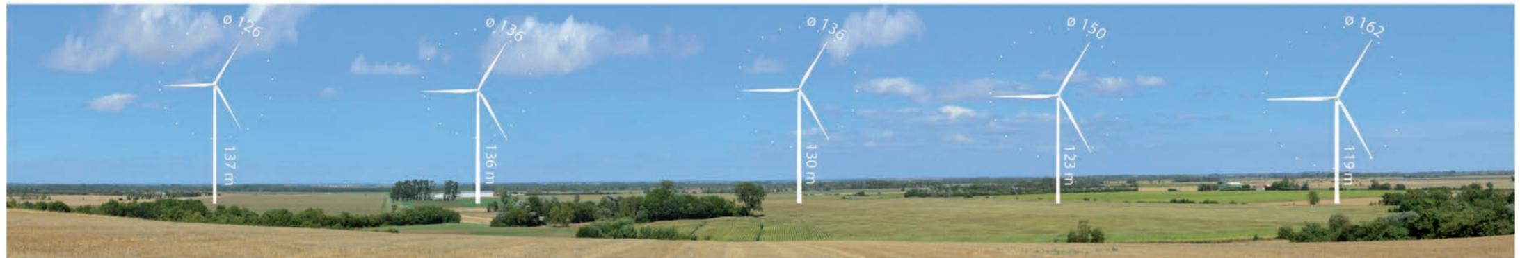
Photographie 117 : Exemple du rapport de proportion entre le diamètre du rotor et la hauteur de mât (éoliennes de 200 m en bout de pale). Source : ENCIS Environnement.
