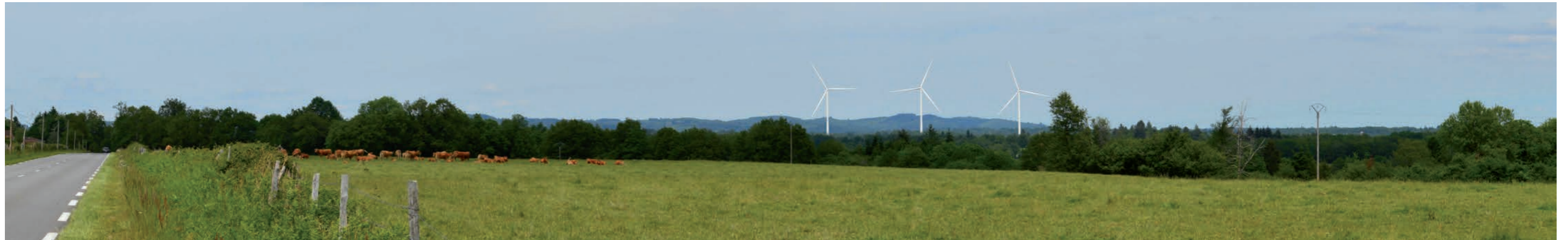
Photographie 154 : Vue en direction du projet éolien depuis le tracé de la D675, le long du principal tronçon de visibilité au sud de l'AER (Vue 7 du carnet de photomontages).
