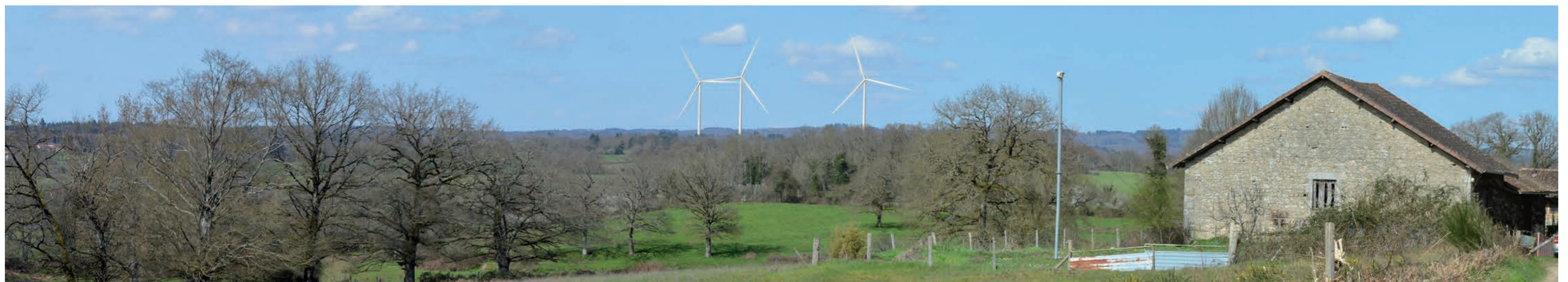
Photographie 172 : Vue sur le projet éolien depuis le chemin d'accès au hameau des Cassines (Vue 25 du carnet de photomontages).
