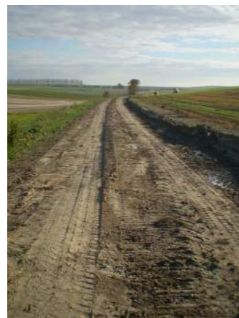
Figure 7 : Remise en état du chemin après rebouchage de la tranchée (Source : wpd)
