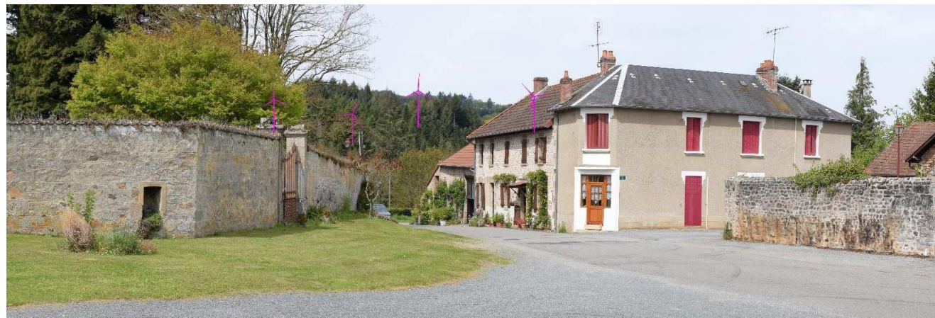
Photographie 121 : Vue vers le projet aux abords de l'église d'Arrènes (esquisse du photomontage n°15 dans le carnet).
