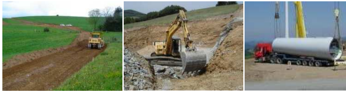
Photographie 101 : illustration d'un chantier éolien.
