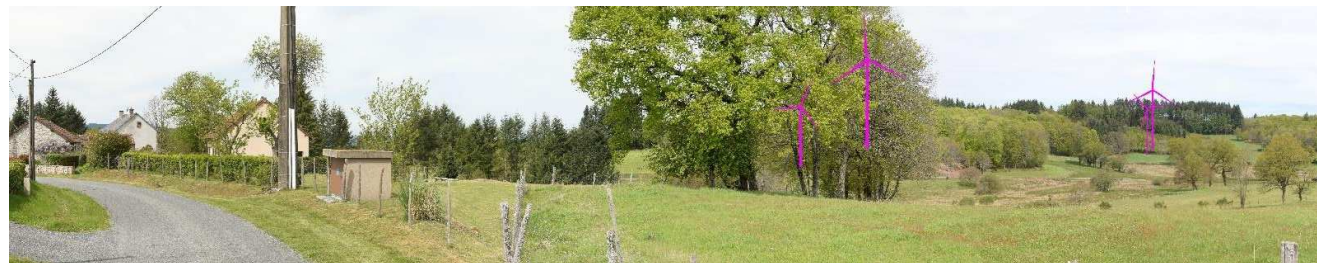
Photographie 147 : Vue vers le projet depuis la route d'accès à La Plaud (esquisse à 120° du photomontage n°5 dans le carnet).
