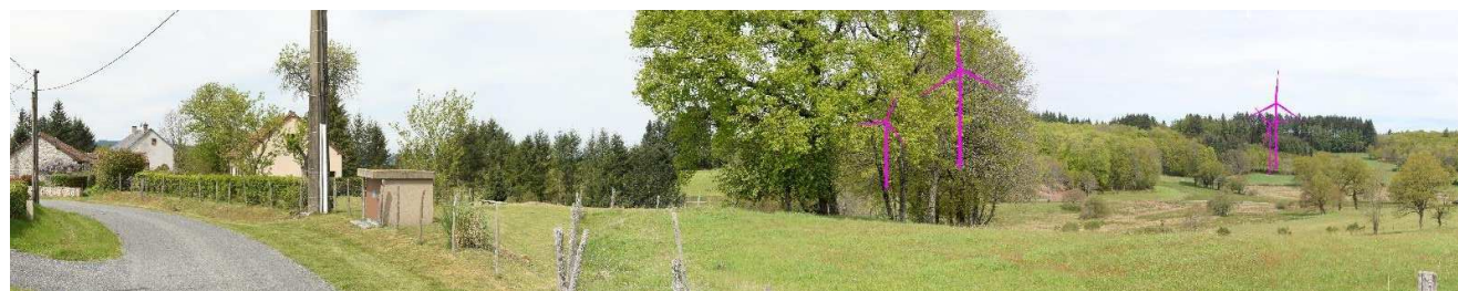
Photographie 154 : Vue vers le projet depuis la route d'accès à La Plaud (esquisse à 120° du photomontage n°5 dans le carnet).
