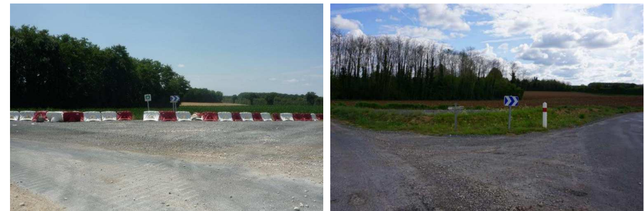
Photographies 161 et 162 : Exemple de réduction de l'emprise d'un virage pour une piste d'accès sur un parc éolien.
