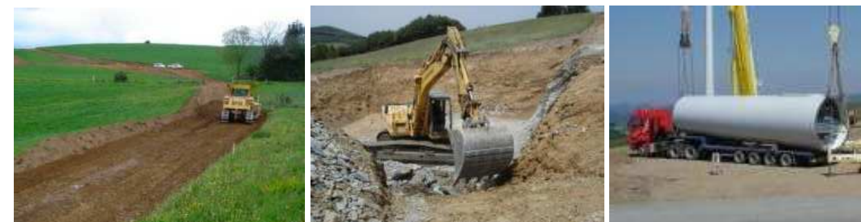
Photographie 26 : illustration d'un chantier éolien
