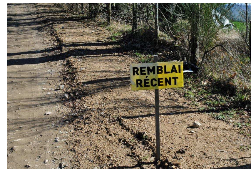
Photographie 24 : Exemple de remblai des tranchées électriques le long d'une piste
