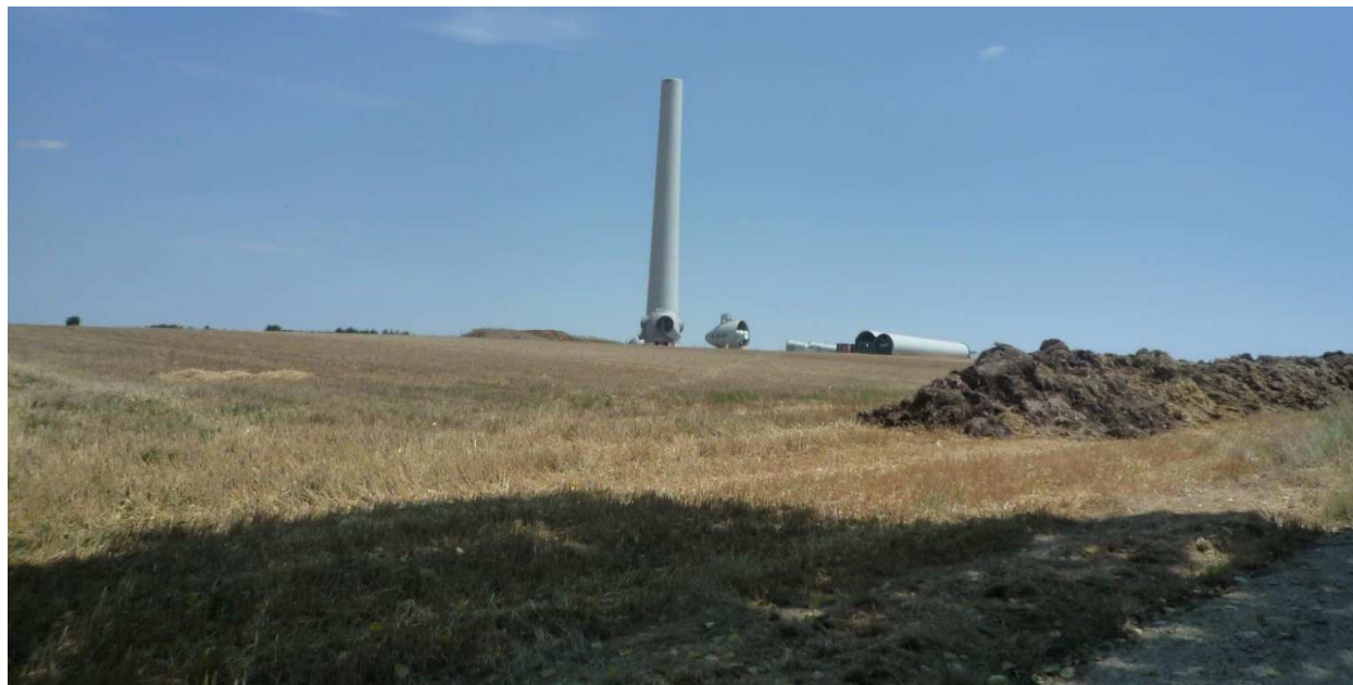
Photographie 23 : Exemple de stockage de terre durant un chantier éolien
