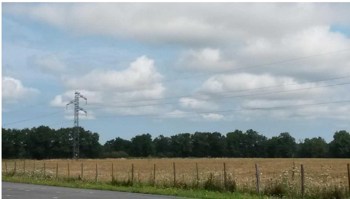
Photo 1 : Ligne haute tension longeant la RN147 au niveau de la section de Berneuil
