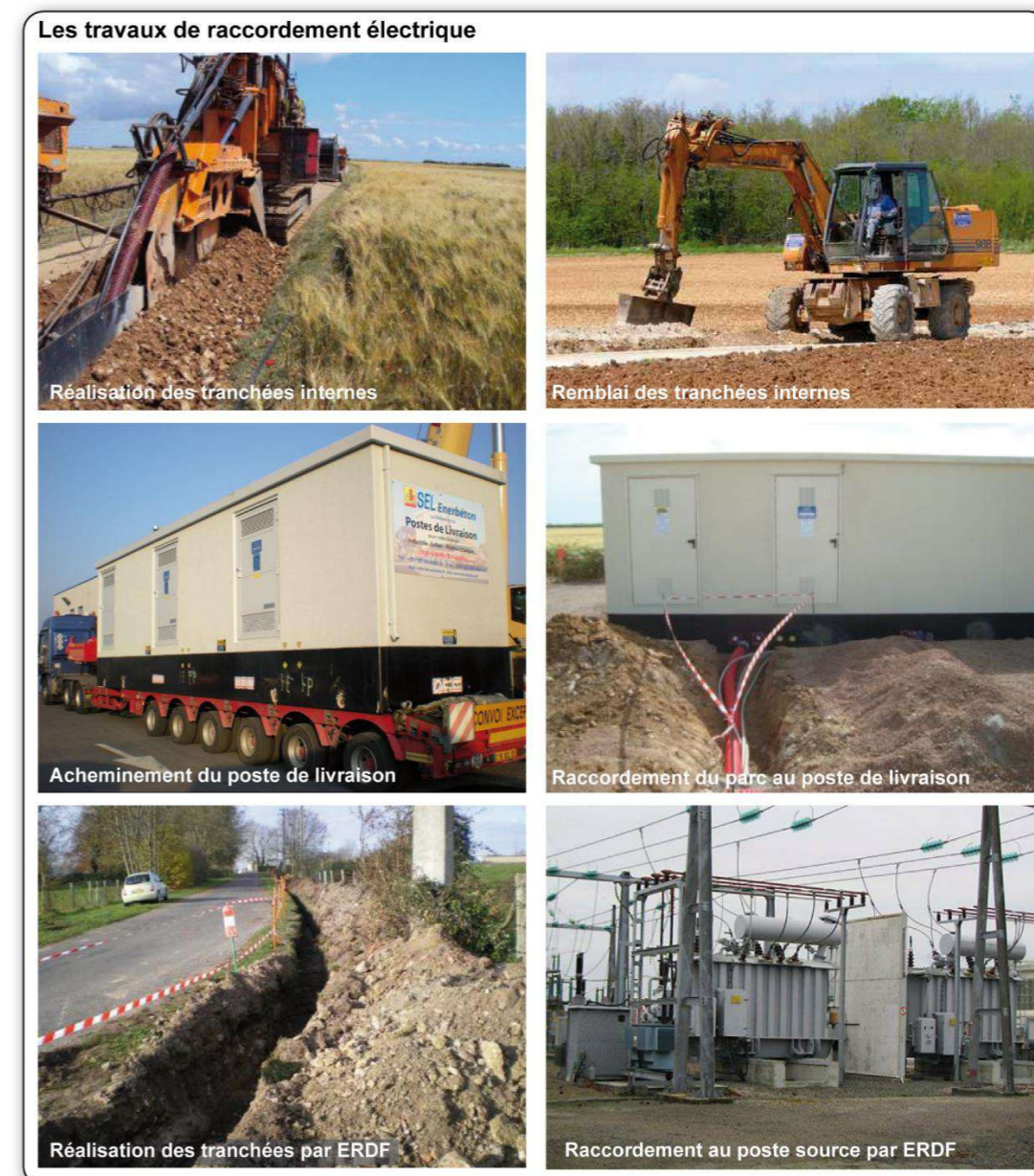
Photographie 40 : Travaux de raccordement électrique
