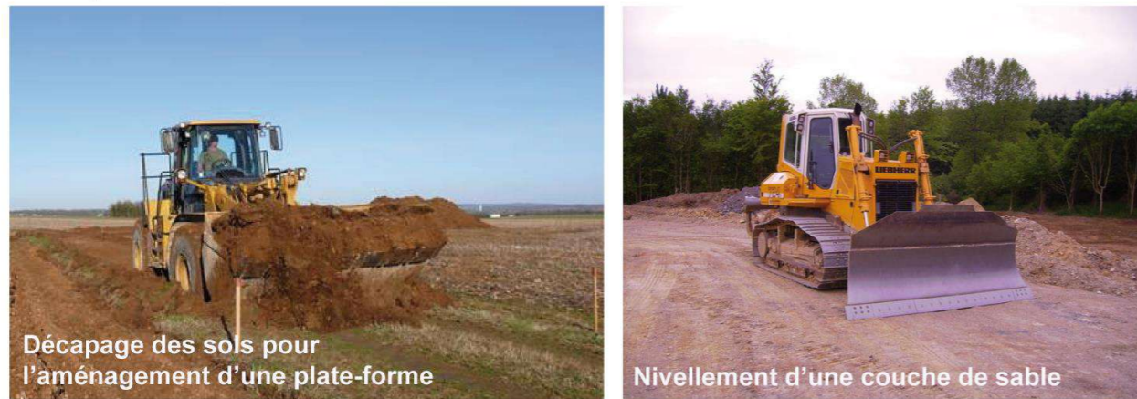
Photographie 38 : Exemples d'engins de travaux de VRD
