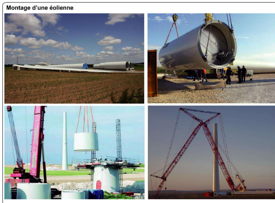
Photographie 41 : Phases d'assemblage d'une éolienne
