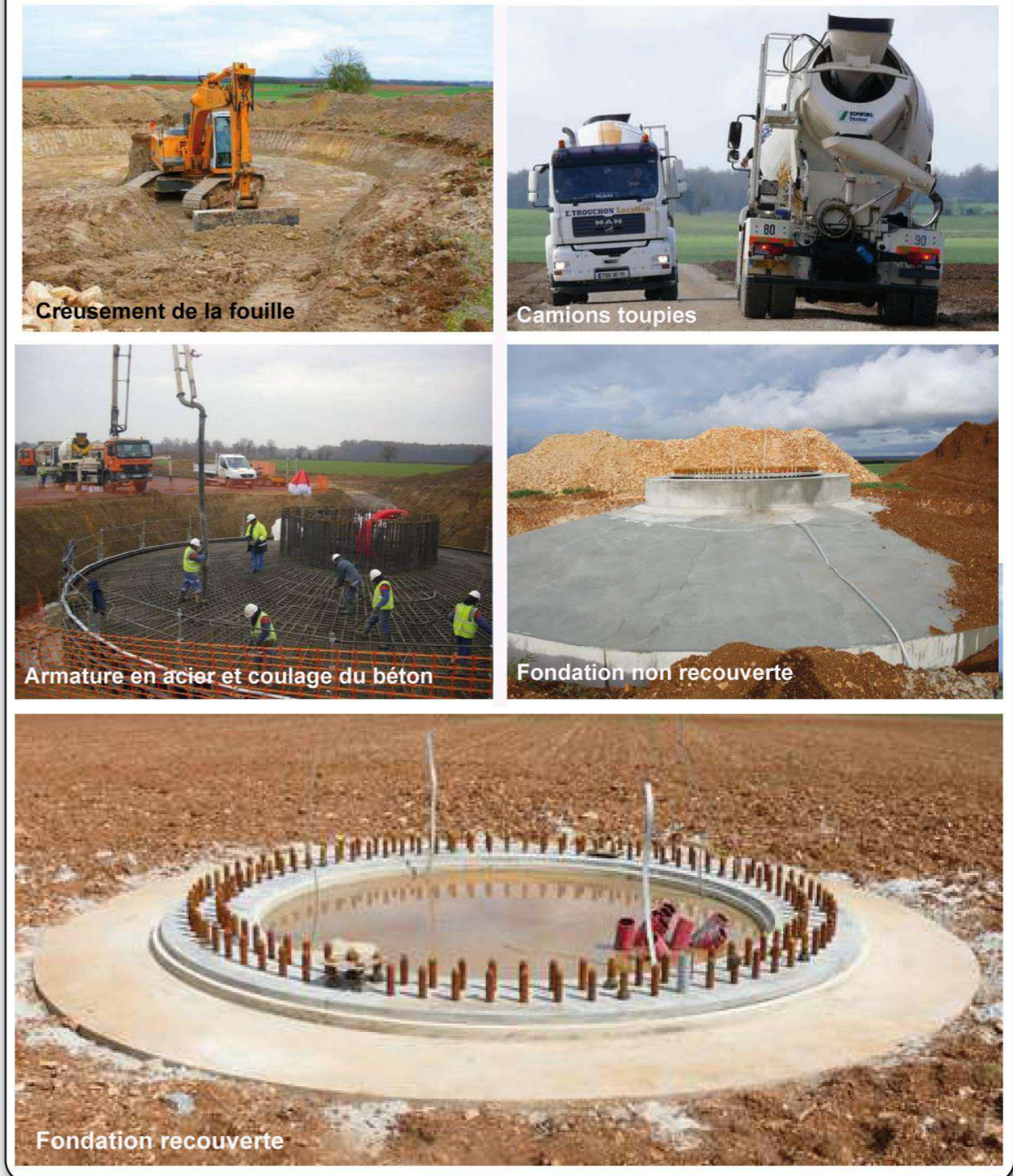
Photographie 39 : Etapes de réalisation d'une fondation d'éolienne
