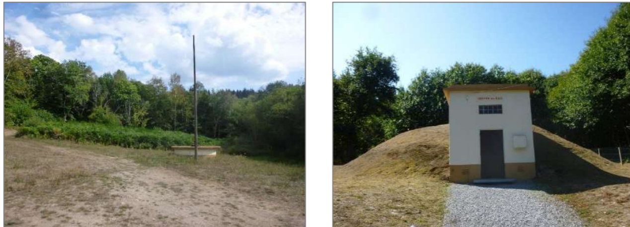
Photographie 16 : Captage de Chatenet-Colon et réservoir d'eau potable (Source : ENCIS Environnement)
